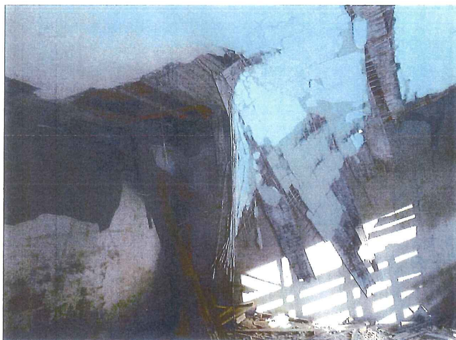
Obr. 5 Detailný pohľad na poškodenie stropu v podzemnej miestnosti
